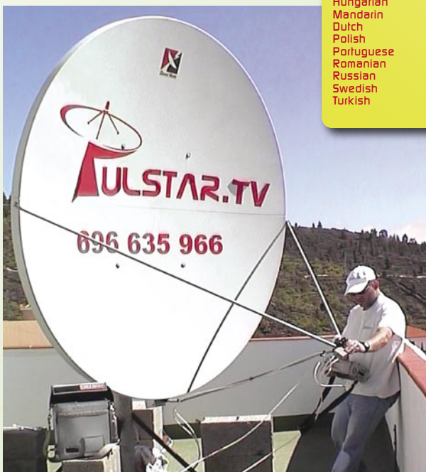
■ La bassa elevazione richiesta per ricevere i satelliti americani complica le cose. Poiché la posizione di Diego è in alto tra le montagne egli è in grado di mantenere la ricezione anche con queste basse elevazioni.
