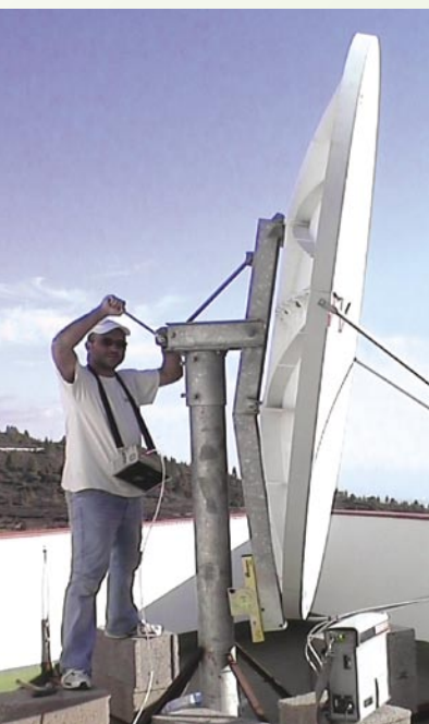
■ La bassa elevazione richiesta per ricevere i satelliti americani complica le cose. Poiché la posizione di Diego è in alto tra le montagne egli è in grado di mantenere la ricezione anche con queste basse elevazioni.
