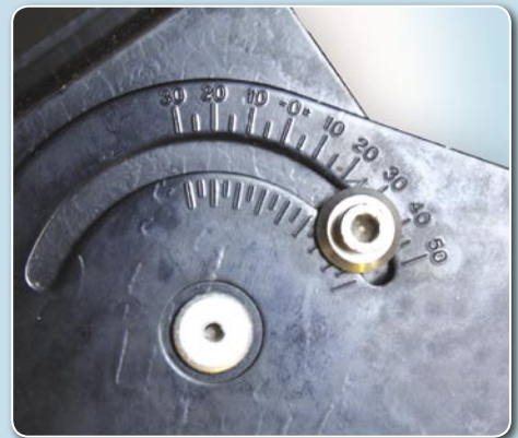
Angolo di elevazione impostato sull'antenna
