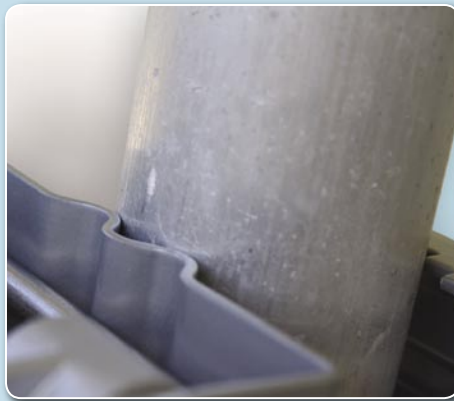
Contrassegno per allineare verso Sud il motore sul palo
