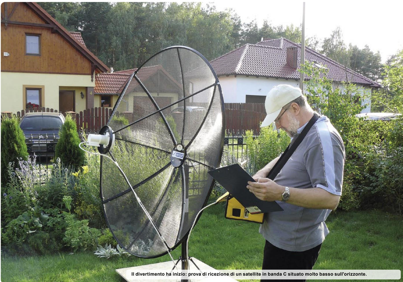
E' il momento di allineare l'antenna. Raccomandiamo l'utilizzo di una livella a liquido con misuratore di angolazione: renderà molto più semplice l'impostazione dell'elevazione.
